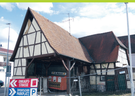
Abriss beschlossene Sache
